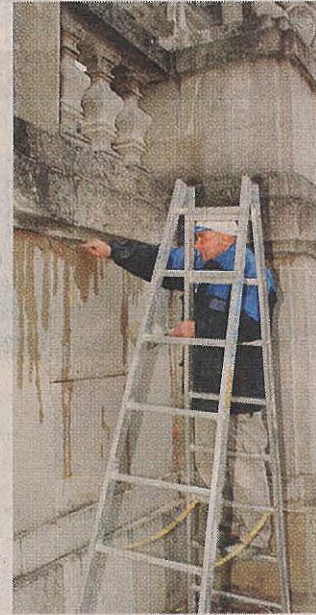
Sanierung der Gloriette-Stiegen
