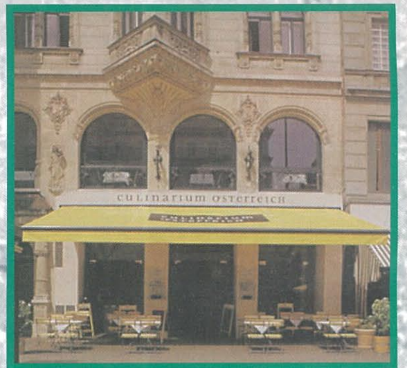
Fassade der Vinothek "Culinarium Österreich" aus Mannersdorfer Kalkstein
